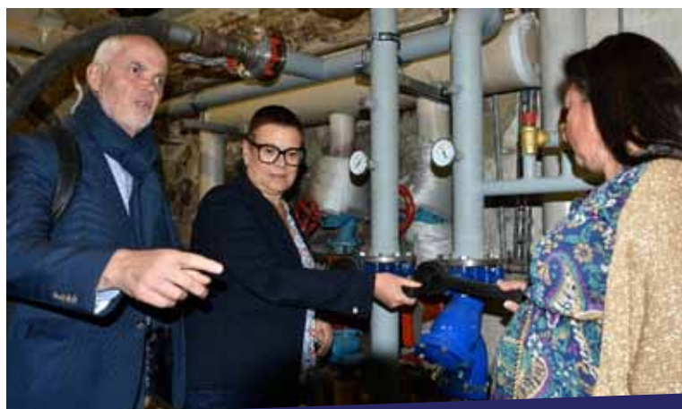
Ouverture des vannes sur le réseau à l'EHPAD Un moment important pour la transition énergétique
