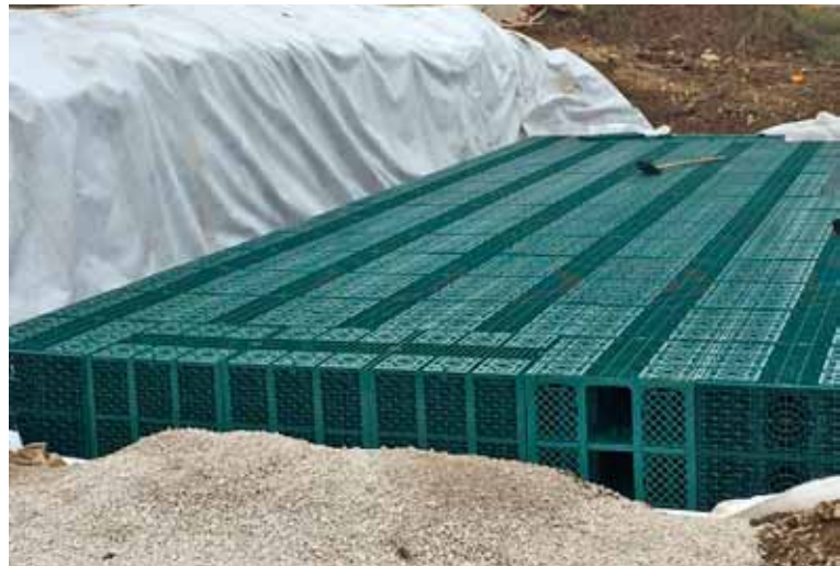
Mise en place du puits perdu
