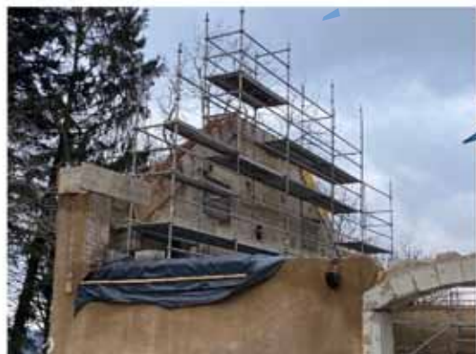
Bétonnage des têtes de murs
